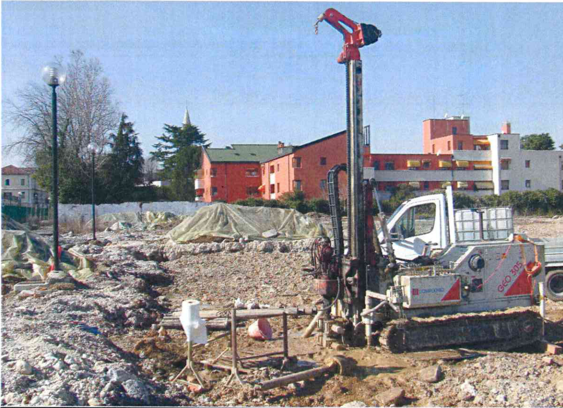
Foto n. 7: ubicazione del sondaggio geognostico S4.
