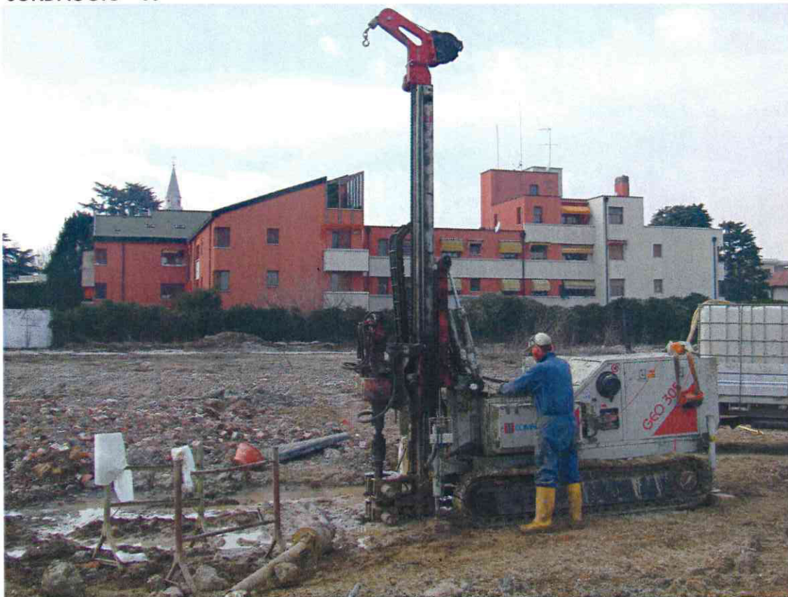
Foto n. 5: ubicazione del sondaggio geognostico S3.
