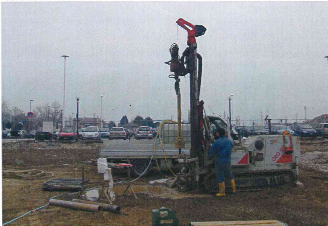
Foto n. 3: ubicazione del sondaggio geognostico S2.
