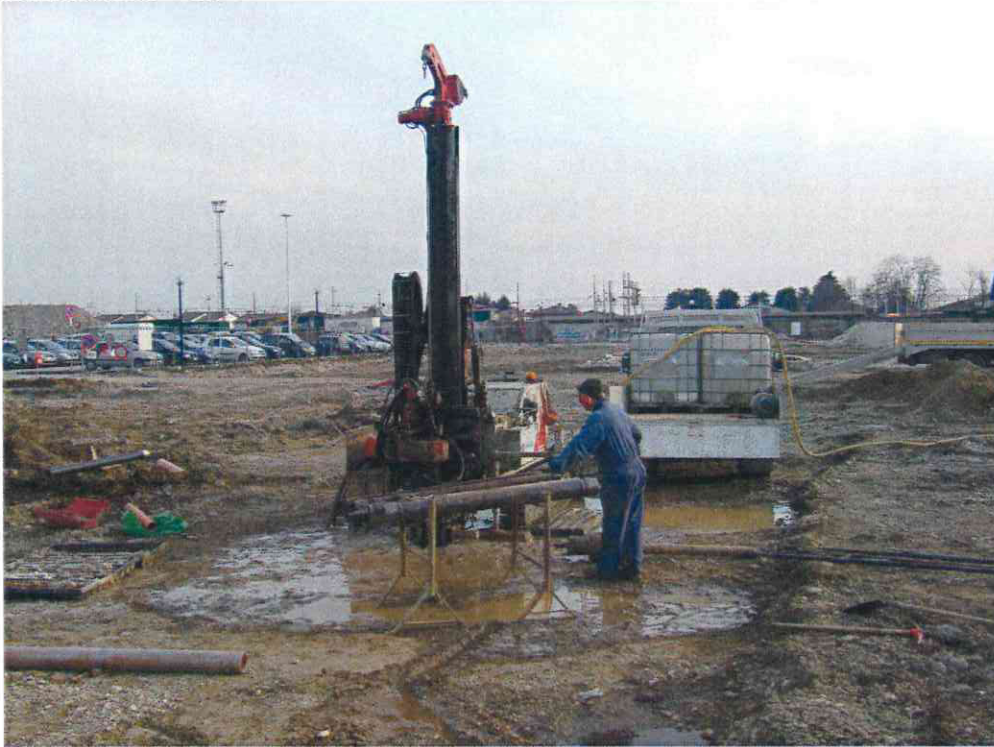
Foto n. 1: ubicazione del sondaggio geognostico S1.
