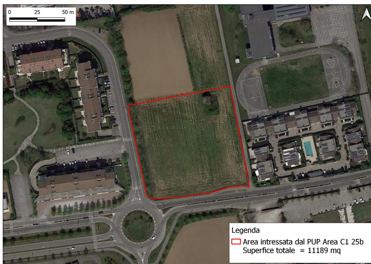
Figura 2: Stato attuale dell'area oggetto di intervento
